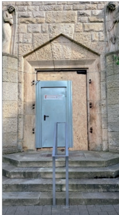
Übergangszeit: Inzwischen ist die Kirchentür im Kloster Neustadt ersetzt
